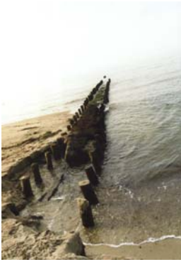
Abbildung 10.45. Auskolkung an der Landseite einer Kastenbuhne führt zum Verlust der landwärtigen Anbindung der Buhne und damit sogar zu einer Ausspülung des luvseitigen Strandmaterials
