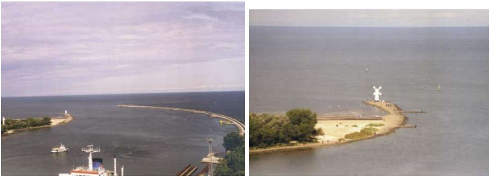
Abbildung 10.47: Molenanlage in Swinemünde
