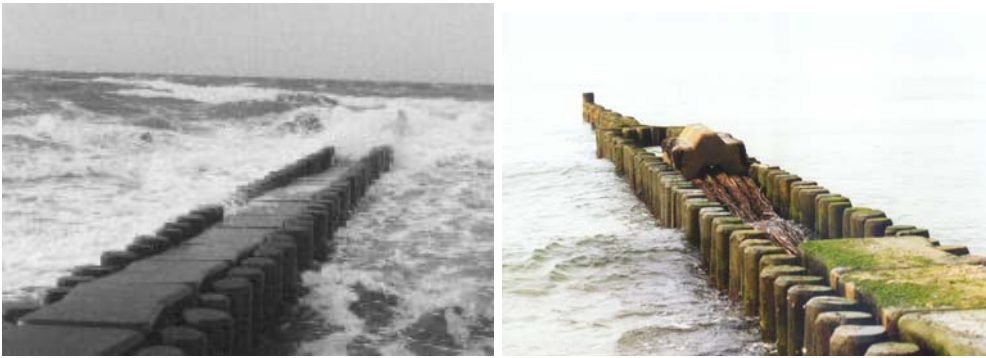
Abbildung 10.44: Kastenbuhne mit aufgenommenen Deckplatten und neu gelegten Faschinen
