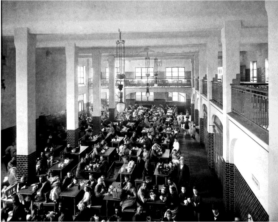
6.3.1.3. oben: Innenansicht des Speisesaals um 1906 (Portier IV)
