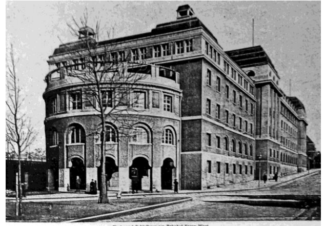
Kost- und Schlafhaus am Bahnhof Essen West.
