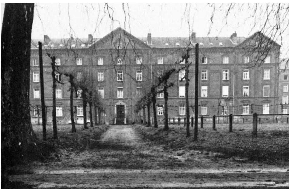
c) Ansicht Zustand 1977
