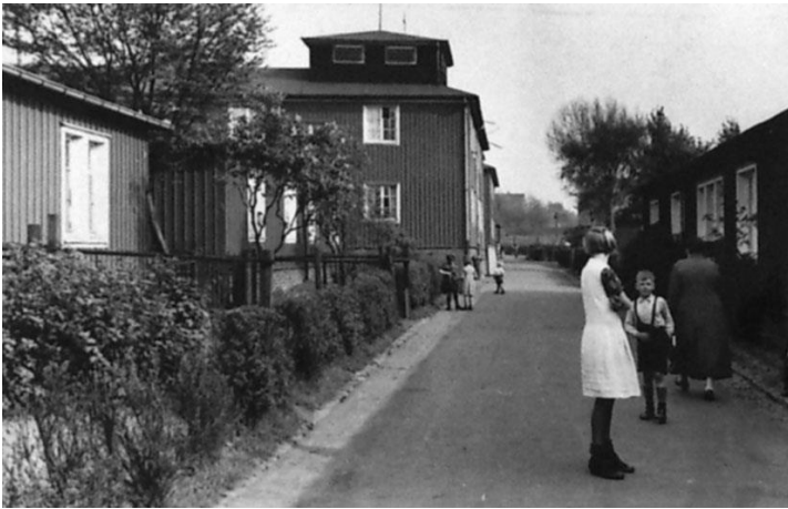
5.3.5.3. Laubenhof: Oben: Dachaufbau bei den Endhäusern, Mitte: eingeschossige Fachwerkbaracken
