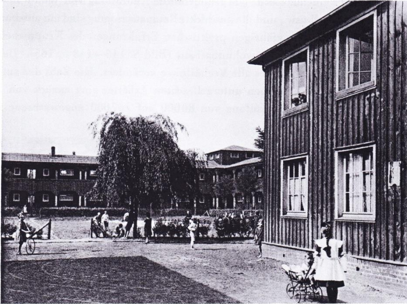
Siedlung Laubenweg am Eselsweg. Notwohnungen 1916
