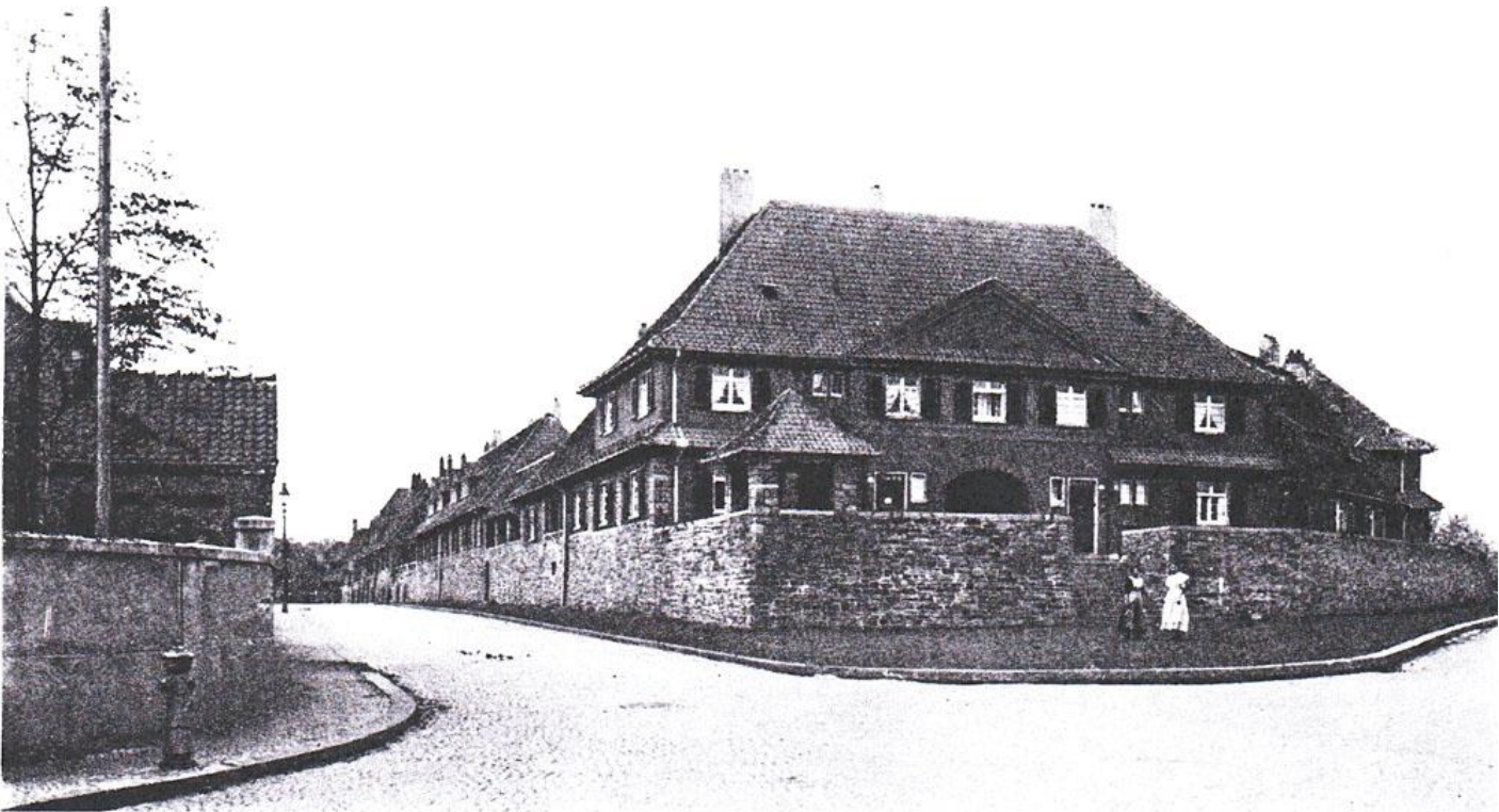
5.3.2.6. Torhaus des Altenhof II mit Freitreppe
