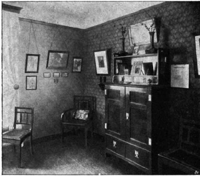
Partie aus dem Wohnzimmer II in der Kolonie Alfredshof. Entworfen von Architekt Stehn, Charlottenburg.
