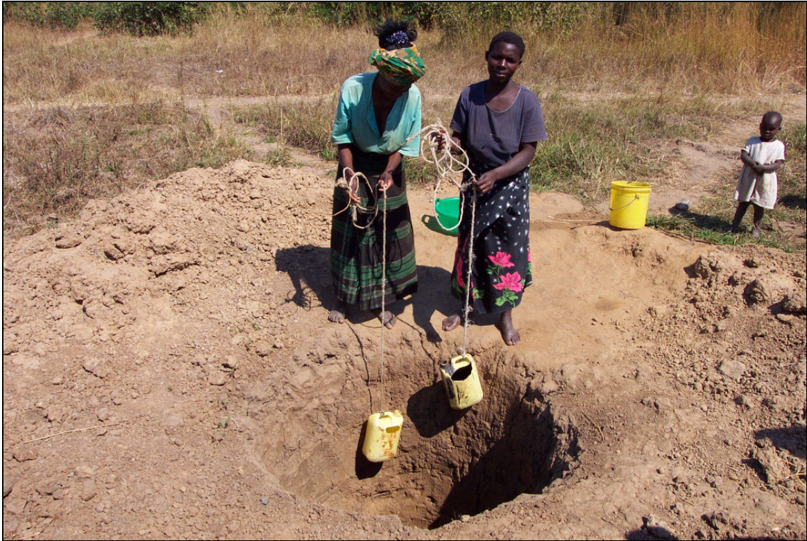
Abb. 18: Ungesicherter offener Brunnen (eigenes Foto)
