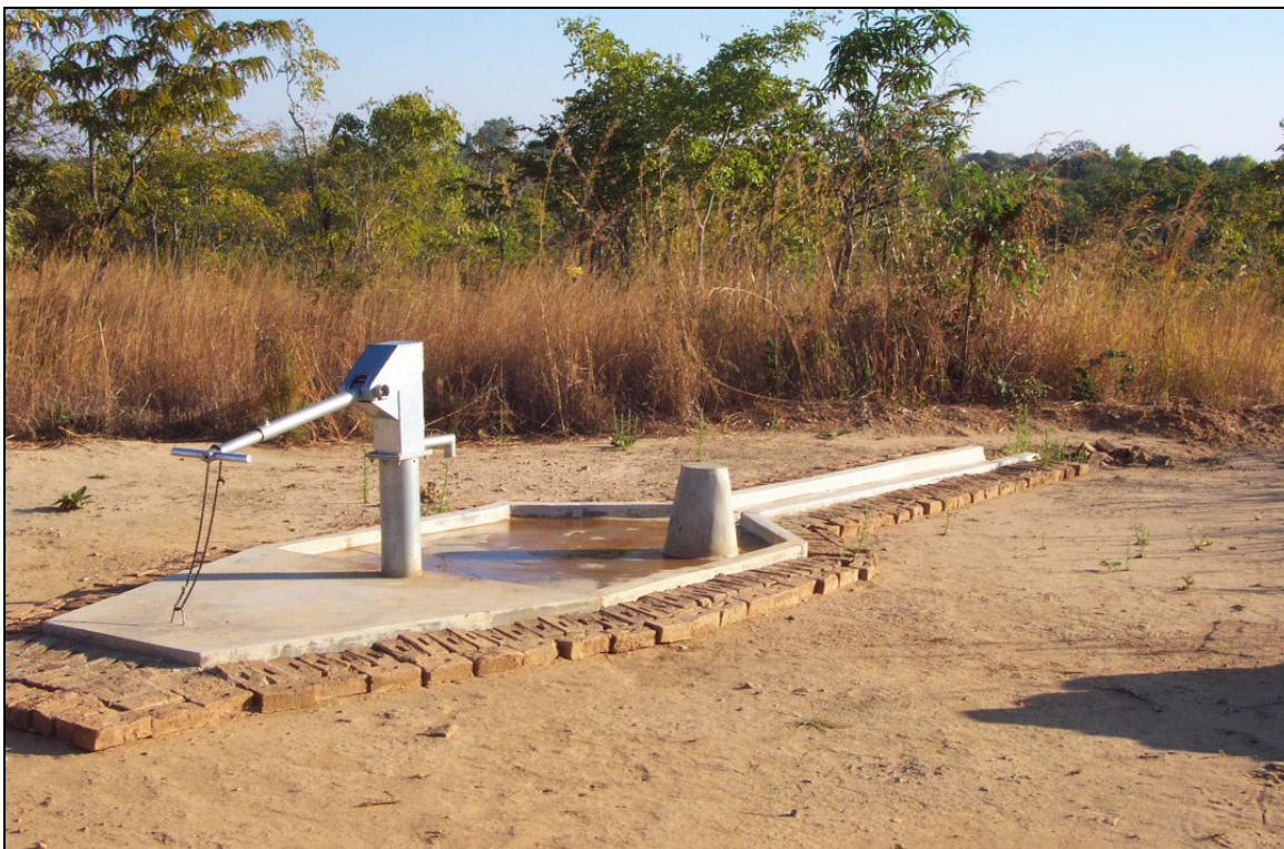
Abb. 39: AFRIDEV Pumpe, mit Schloss und Kette gesichert (eigenes Foto)
