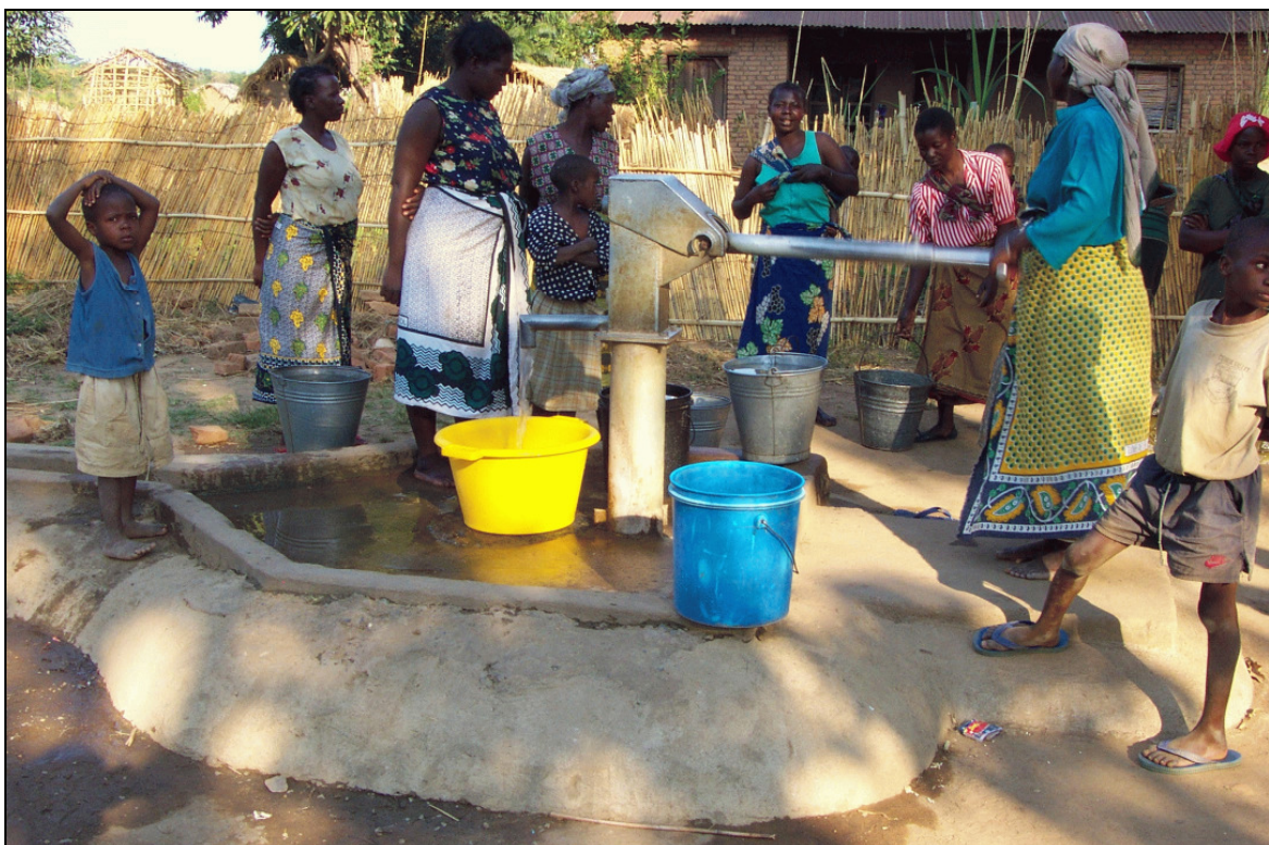
Abb. 22: Bohrbrunnen mit AFRIDEV Pumpe (eigenes Foto)
