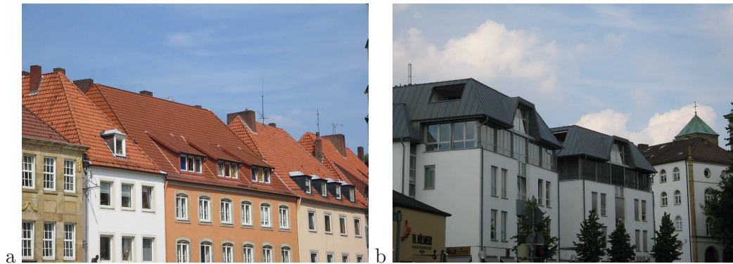
Abbildung 7.4: Unterschiedliche Dachmaterialien a) Ton und Beton, b) Metalldächer, vorn Zink, im Hintergrund oxidiertes Kupferdach (Dom)
