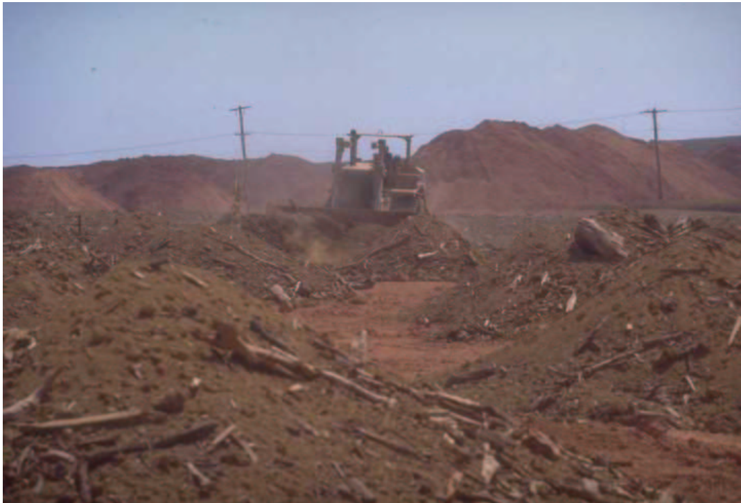
Abbildung 5.7: Nachdem die Grube mit dem gelben Latosol wieder gefüllt und begradigt wurde, wird der Oberboden mit Lastwagen von der vorher schon von Biomasse befreiten Fläche geholt und in Haufen auf die aufzuforstende Fläche geschüttet und mit einem Raupenbagger verteilt. Die Schicht ist dann etwa 20-40 cm dick. In diesem Oberboden befinden sich noch viele Samen aus dem Primärwald und etliche noch keimungsfähige Pflanzenteile.
